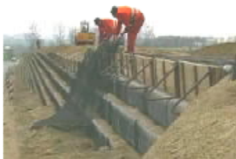
є) укладання нового шару
