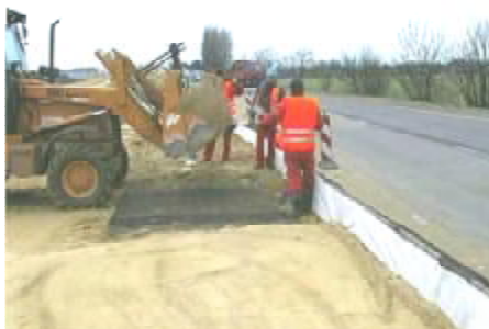
д) засипання армуючого полотна ґрунтом
