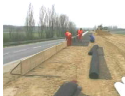
б) встановлення тимчасової опалубки
