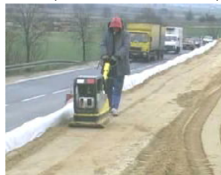
е) ущільнення торцевої частини ручною віброплитою
