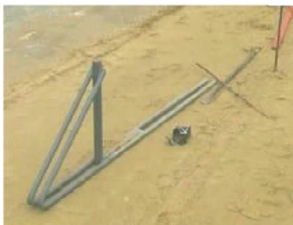
а) металевий упор опалубки
