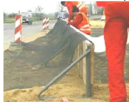
г) укладання торцевої геотекстильної прокладки
